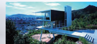
現代の高床式住居 毘沙門の家 竣工:2003年4月 所在地:広島県広島市 / 鉄骨造 地上3階建 敷地面積 701.59㎡ 延床面積 189.88㎡ 建築面積 80.2㎡
