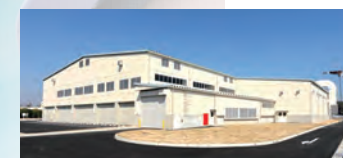
出島埋立地区廃棄物処分場 受入施設建築工事 管理棟新築工事:鉄骨造平屋建 受入施設新築工事:鉄骨造2階建 既設外構撤去工事 / 外構工事 / 植栽工事 敷地面積 19,371.54㎡ 延床面積 5,601.16㎡
