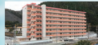
市営住宅御園団地6号棟 新築工事 鉄筋コンクリート造 8階建 敷地面積 7,507.95㎡ 延床面積 1,017.64㎡ 建築面積 5,621.21㎡
