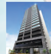
プレサンスロジエ 広島駅南 新築工事
